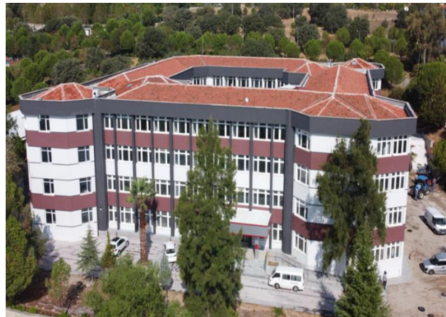
İşletme ve İletişim Fakültesi Binası Bakım Onarımı
