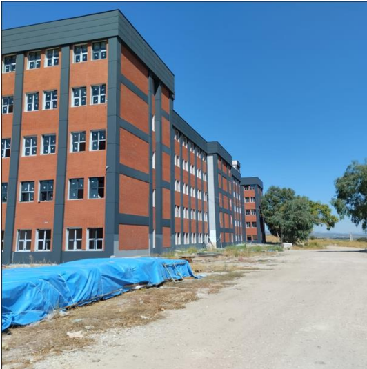
MCBÜ Derslik ve Merkezi Birimler İnşaatı
