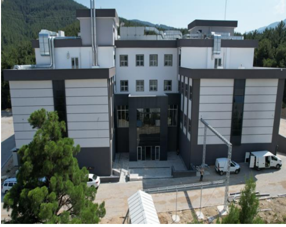
MCBÜ Onkoloji Hastanesi Tamamlama İnşaatı
